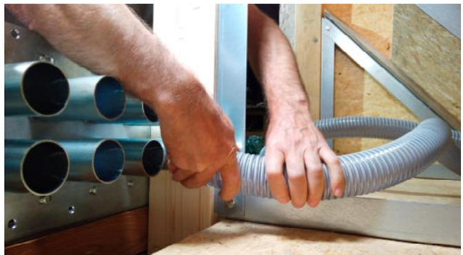
Stecken Sie die innenliegenden Saugschläuche (Verbindung zu den Saugsonden) auf die Schlauchanschlussstutzen der Schlauchanschlussplatte und fixieren Sie die Schläuche mit den Schlauchschellen.
