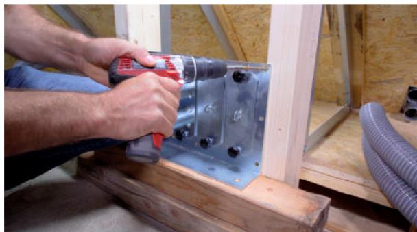
Verschraubung der Schlauchanschlussplatte an einer geeigneten Stelle
