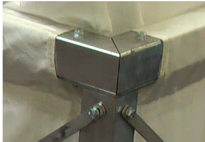
Details der Eckverschraubung
