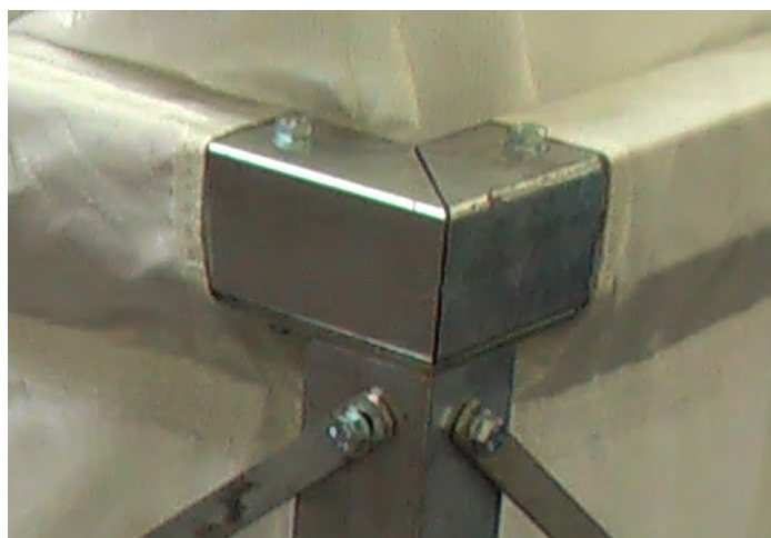
Details der Eckverschraubung
