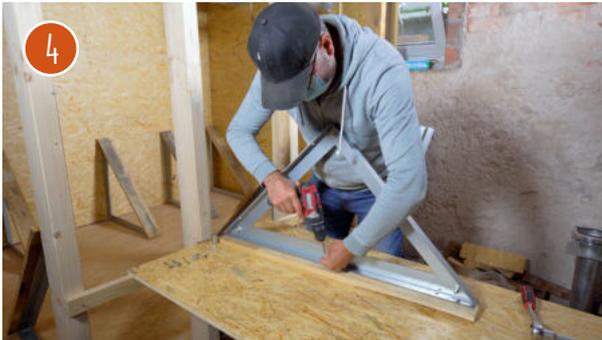
Bauen Sie zuerst den [Winkelrahmen](#) zusammen. Die 3 Winkelschienen ergeben ein Dreieck und bilden automatisch die 45° Auslaufschräge.
