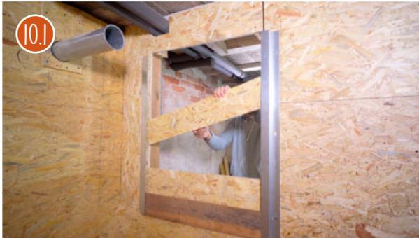
Nachdem Sie die [Z-Schienen](#) für den Einstieg montiert haben, schieben Sie die einzelnen Türschutzbretter von außen in den Rahmen.
