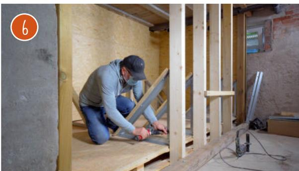
Nachdem die Wandverkleidung angebracht ist, installieren Sie die [Winkelrahmen](#) zur Herstellung der zweiten Schräge.
