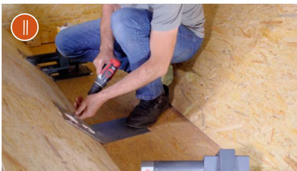
Die Entnahme aus diesem Schrägbodenlager erfolgt per [Saugsonden](#). Setzen Sie dazu die [Montageplatte für Saugsonden](#) ein. Diese erleichtert das Anbringen der Saugsonde, da Sie nur einen rechteckigen Ausschnitt in den Holzschrägen brauchen.
