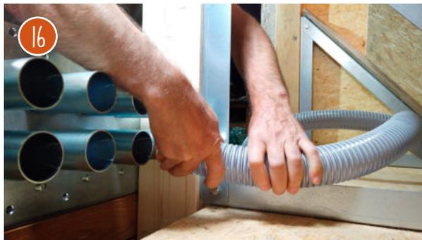
Befestigen Sie den Schlauch an den Stützen des Saugbahnhofs. Vertauschen Sie nicht die Rückluft- und Saugleitung und achten Sie darauf die Erdungslitze mit einzuklemmen.
