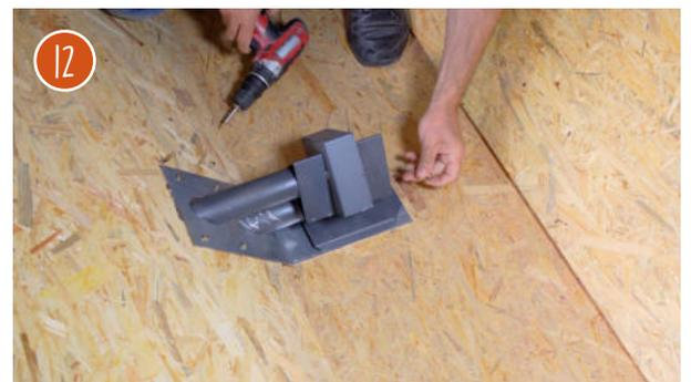
Jetzt befestigen Sie die 5 [Saugsonden](#) mit langen Stützen an der [Montageplatte](#) bzw. am Boden.
