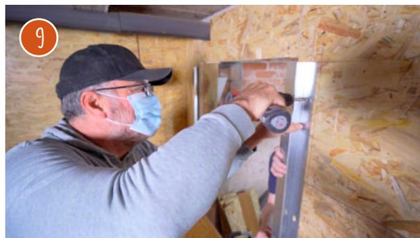
Jetzt ist Ihr Lagerraum fast fertig. Damit Sie Ihr Pelletlager auch betreten können, ist ein Einstieg in den Lagerraum notwendig. Eine große Hilfe sind hier [Z-Schienen](#) für die Lagerraumtür. Diese schrauben Sie an Ihren vorbereiteten Einstieg.
