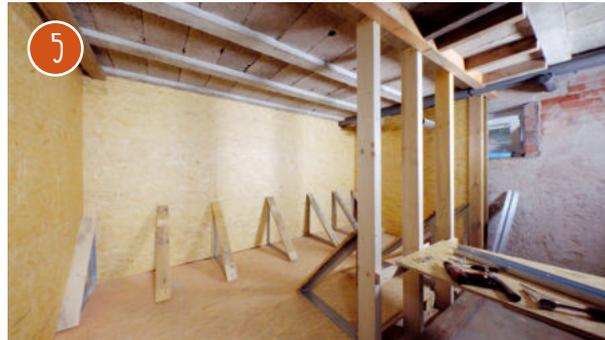
Um die Holzplatten für den Schrägboden anbringen zu können, schrauben Sie auf jeden Winkelrahmen ein zusätzliches Holzbrett. Jetzt können Sie die Balken für die zusätzliche Seitenwand stellen.
