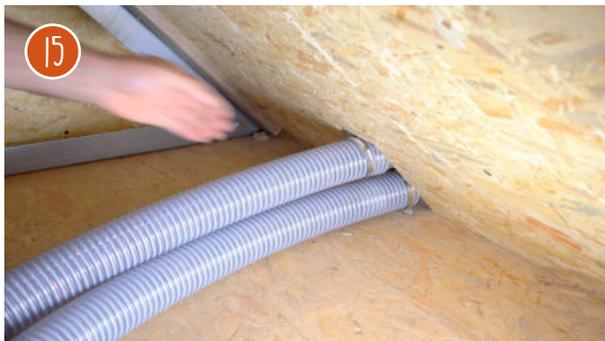
Mit den Schlauchschellen fixieren Sie den Schlauch ganz einfach an den Stützen der Saugsonden.
