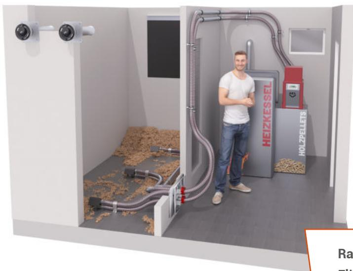
Ihr Raum ist kleiner und hat eine Grundfläche zwischen 1,5 m<sup>2</sup> und 3 m<sup>2</sup>? Dann lagern Sie die Pellets doch direkt am Boden. Trotz kleiner Grundfläche erreichen Sie ca. 4 Tonnen Lagermenge.
