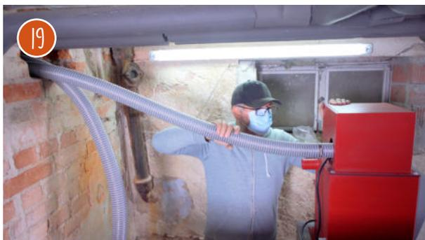
Als letzten Schritt verbinden Sie die Schläuche mit Ihrem Saugsystem. Das Saugsystem kann entweder in Ihrem Kessel sein oder Sie verwenden wie in diesem Projekt den externen Pelletsauger Vacupellet.
